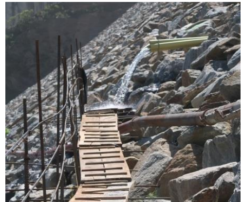
Figura 13-87 Filtraciones del espaldón de aguasabajo de la presa, elevación aprox. 380 msnm, antes de la construcción del muro corta flujo, que para entonces totalizaban del orden de 30 l/s o más (Pöyry, 2019a)
