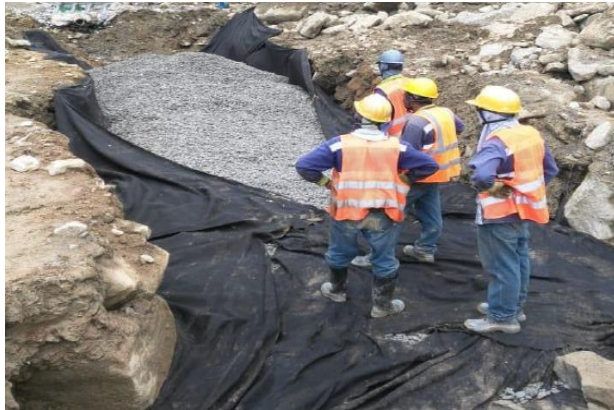
Figura 13-86: Instalación de un colector de filtración y tuberías conectadas para conducir los caudales que pasan a través del relleno prioritario a las cámaras de recolección (Ingetec-Sedic S.A., 2019e)
