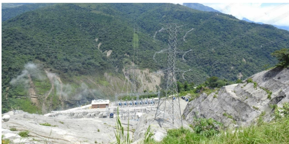
Figura 13-60: Vista de la S/E de Ituango, amagada por inestabilidades puntuales y en reparación
