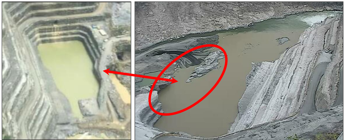
Figura 13-114: Vista al cuenco amortiguador en mayo 2018 antes del destaponamiento del TDD (izquierdo) y en diciembre 2018 después de la primera operación del vertedero (derecho), (fuente presentación Integral)
