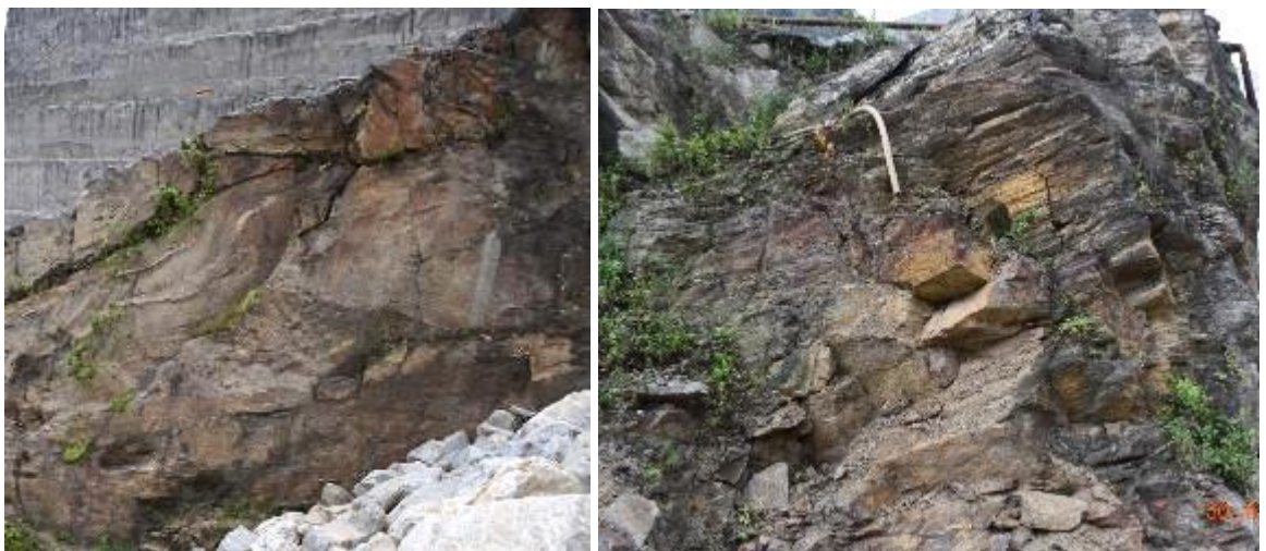
Figura 13-6: Aspectos del gneiss en el sitio de la presa, con sectores donde se aprecia una foliación más esquistosa que gnéisica, tal como se ha apreciado en los cortes para soporte del deslizamiento Romerito
