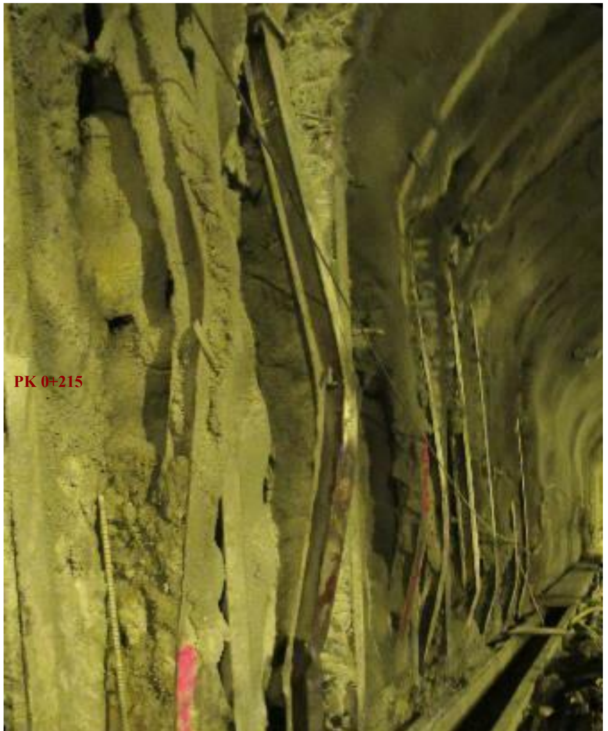
Figura 13-54: Sector con marcos metálicos deformados, en el Km 0+215 del Túnel Vial
