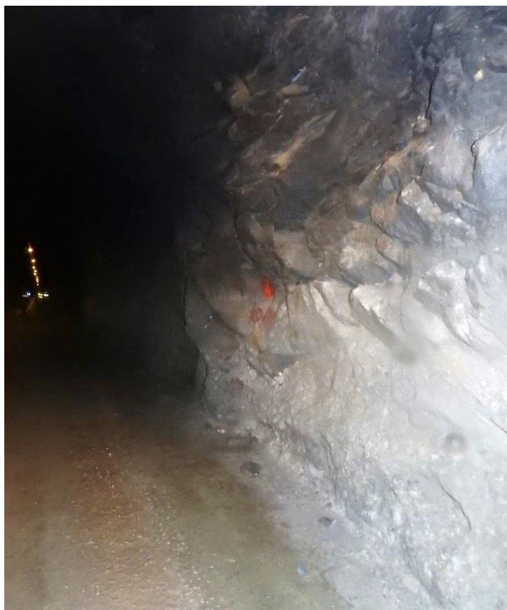
Figura 13-67: Roca de buena calidad geotécnica (IIB) en el Ex-Túnel Vial izquierdo (Galerías 311-313), inspeccionada durante la visita de septiembre de 2021
