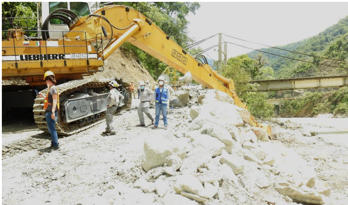
Figura 4-6: Vista del inicio de los trabajos de dragado con una potente excavadora del lecho o cauce del río Cauca, frente y aguas debajo de los portales de los Túneles de Descarga
