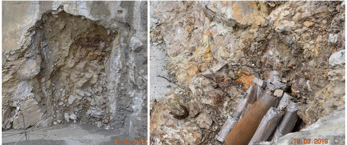
Figura 13-66: Aspecto de la roca en fundación del núcleo en el estribo izquierdo por encima de la cota 418 msnm de mala calidad geotécnica, Marzo 2019
