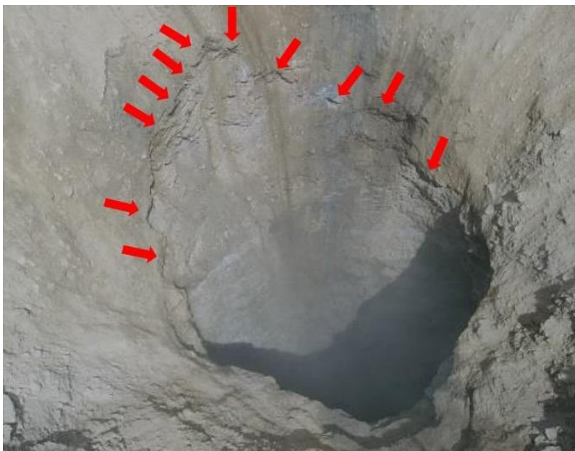
Figura 13-58: Vista del embudo o cráter de subsidencia originado por el colapso final de la GAD, el 30 de abril de 2018. Las flecha indica la transición de suelo a roca.
