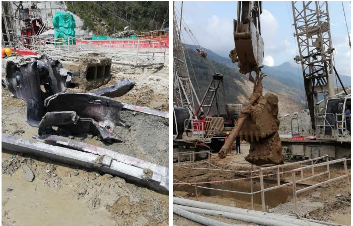
Figura 13-81: Cucharón de almeja ( Clam shell ) recuperada en panel 55 (25 de enero, 2019) (Ingetec-Sedic S.A., 2019e)
