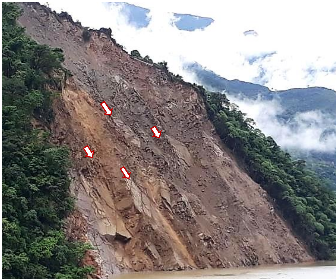
Figura 13-11: Derrumbe en ladera derecha cerca y por encima de los portales de los túneles de desvío. Importante desarrollo de las juntas longitudinales sub verticales (Fecha 16.5.18, fuente: EPM), que facilitan la caída de cuñas y fallas planas.
