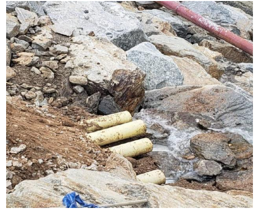
Figura 13-86: Instalación de un colector de filtración y tuberías conectadas para conducir los caudales que pasan a través del relleno prioritario a las cámaras de recolección (Ingetec-Sedic S.A., 2019e)
