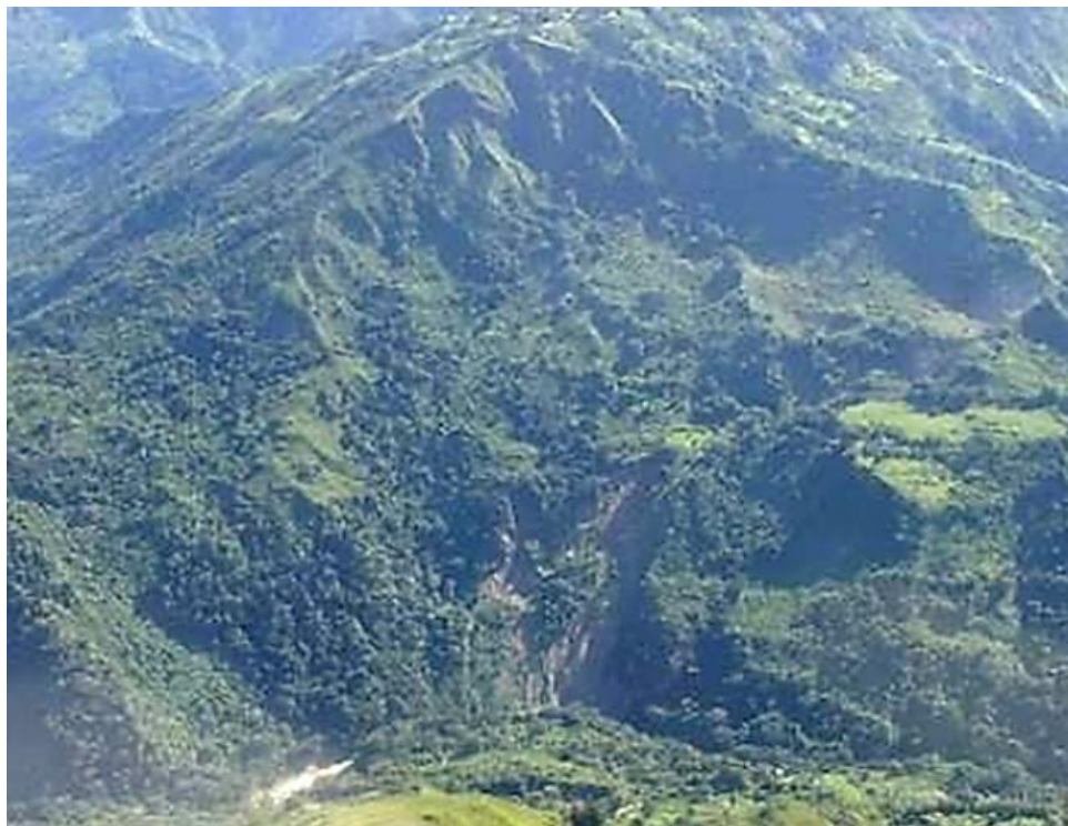
Figura 8-5: Sitio inestable Caparrosa. Reactivación local en material del paleo-derrumbe
