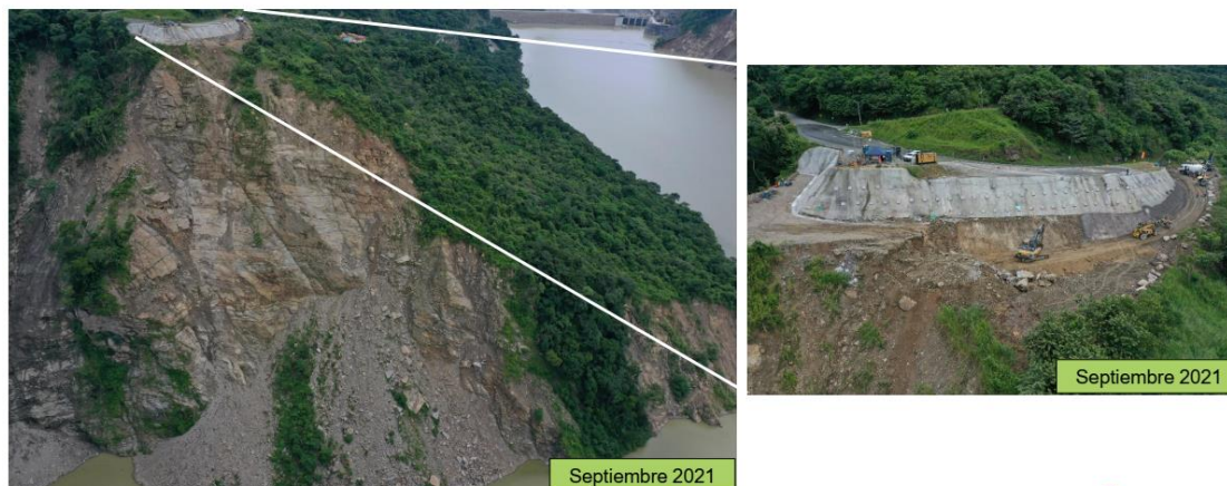
Figura 5-4: Fotografía del sector Helipuerto Villaluz y los trabajos ejecutados
