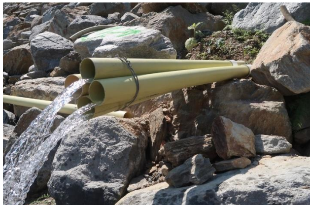
Figura 13-87 Filtraciones del espaldón de aguasabajo de la presa, elevación aprox. 380 msnm, antes de la construcción del muro corta flujo, que para entonces totalizaban del orden de 30 l/s o más (Pöyry, 2019a)
