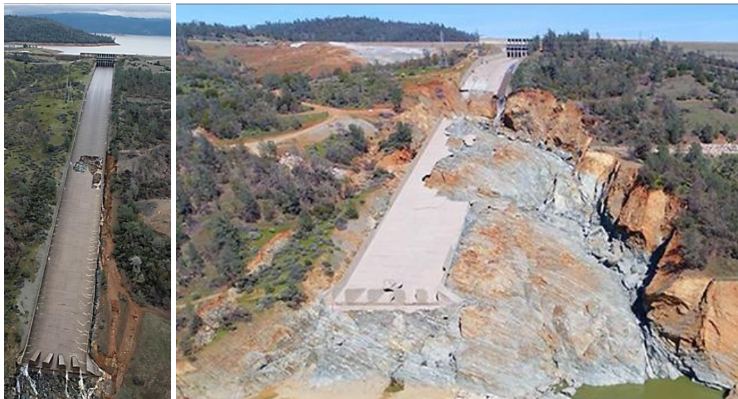
Figura 7-1: Situación del vertedero Oroville, al comienzo y al final del incidente en 2017
