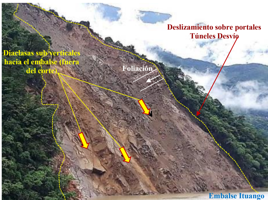
Figura 13-59: Vista del deslizamiento ocurrido sobre los portales de túneles de desvío, el 16 de mayo de 2018, correspondiente al 2º pulso o evento de este colapso
