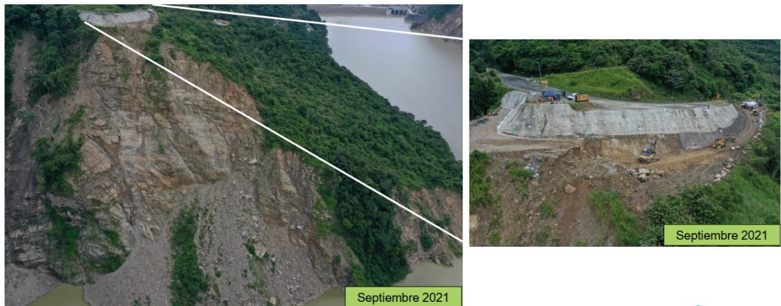
Figura 13-74: Fotografía del sector Helipuerto Villaluz y los trabajos ejecutados
