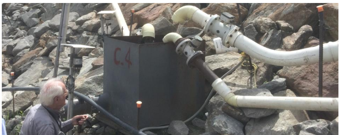
Figura 13-88: Medición de caudal de filtración pasando por la presa en la sección del muro corta flujo
